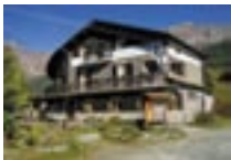
RIFUGIO - RISTORO CHIESA VALMALENCO
