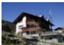
APPARTAMENTI CEPINA Casa del Cacciatore Via Dosso della Benedizione, 10a Tel. 0342/951.136 www.valdisotto.com
