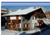
APPARTAMENTI Chalet Gardenia BORMIO Via Santa Barbara, 29a Tel. (+39) 0342 901.346 www.bormio.it/viasantabarbara
