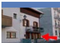
APPARTAMENTI Appartamento Givan ISOLACCIA Via Nazionale, 12 Tel. (+39) 333 83.47.699 www.valdidentro.it
