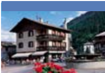
APPARTAMENTI Casa Viola ISOLACCIA Piazza IV Novembre, 16 Tel. (+39) 0342 921.113 www.valdidentro.it
