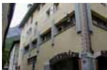
APPARTAMENTI Appartamento Marco BORMIO Via Trento, 2 Tel. (+39) 0342 90 21 16
